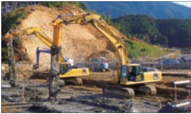
スラリー施工
